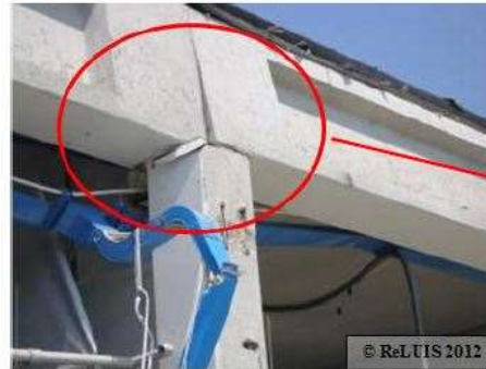
Inadeguatezza del vincolo trave – colonna con danneggiamenti locali del pilastro e rotazioni permanenti della trave in copertura (*)
