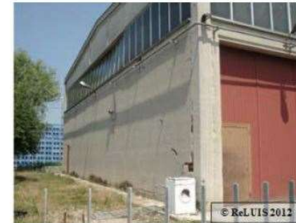
Collasso e fessurazione del pannello di tamponatura in laterizio in una struttura prefabbricata monopiano di recente costruzione (*)
