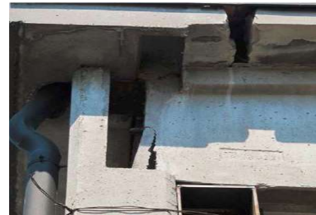
Incipiente perdita di appoggio di una trave principale
