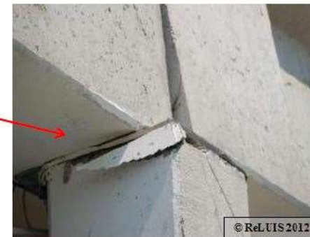
Inadeguatezza del vincolo trave – colonna con danneggiamenti locali del pilastro e rotazioni permanenti della trave in copertura (*)
