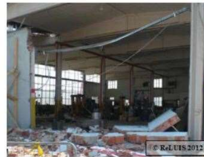
Collasso e fessurazione del pannello di tamponatura in laterizio in una struttura prefabbricata monopiano di recente costruzione (*)
