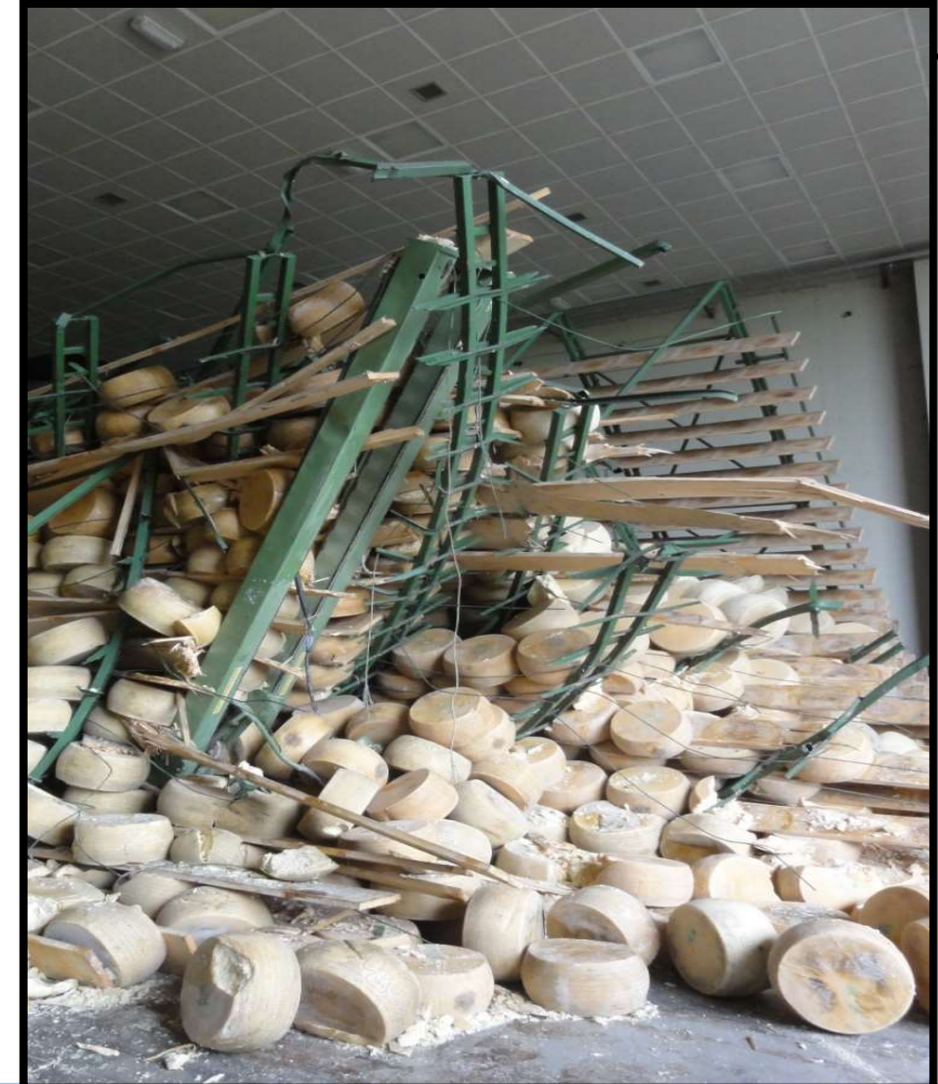
A destra: Crollo di una scaffalatura
