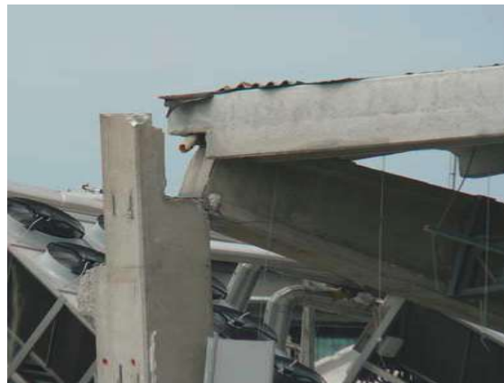
Perdita di appoggio della capriata
